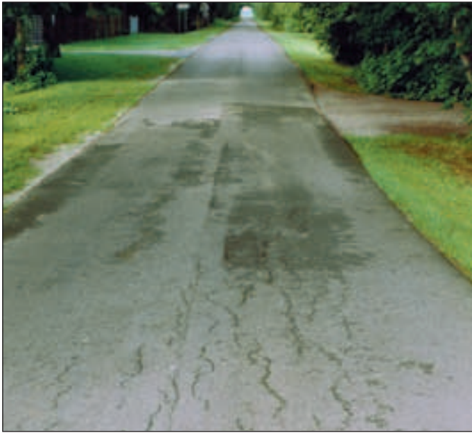
Scharreler Dammweg, Duitsland 1990, vóór wegdekvernieuwing
