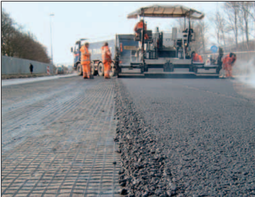
Installatie van HaTelit® in Nederland 2002
